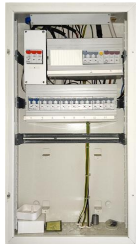
Forenklet vurdering av det elektriske anlegget - [Sikringskap utleiedel]
