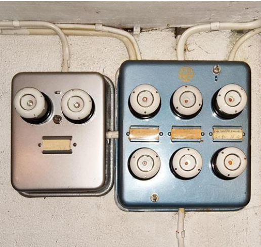
Forenklet vurdering av det elektriske anlegget - [Sikringer i kjeller]
