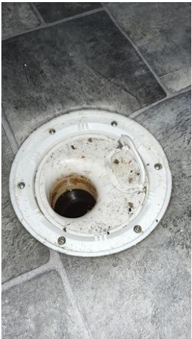
Overflater gulv - [Sluk bod]
