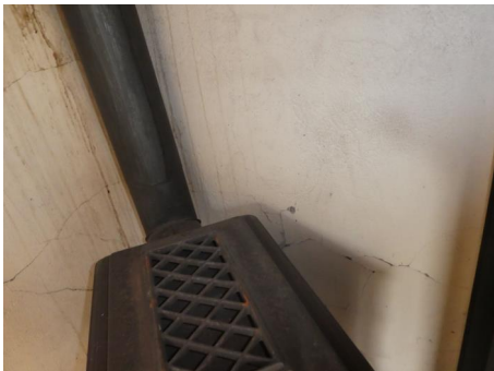
Sprekker og rennemerker på overflater
