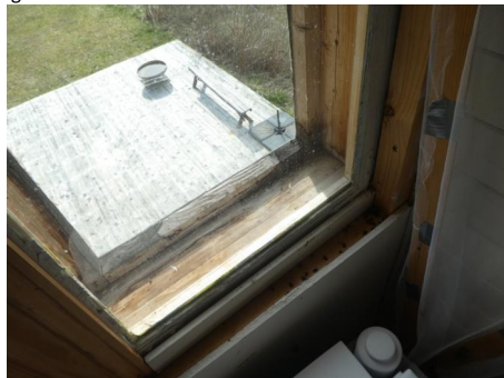
Fuktskade på vindu
