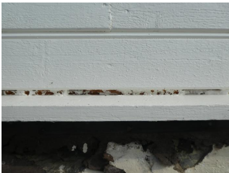
Byggeskum i overgang mellom panel og vannbrett
