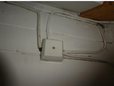
Ufagmessig utførelse av ledningsopplegg
