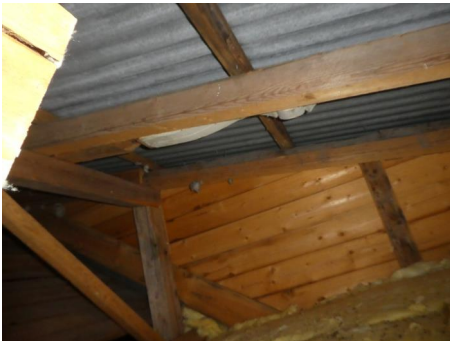
Metallplater synlig på undersiden av takteking
