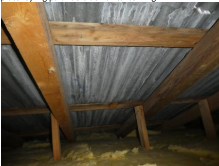
Isolasjon nært undertak på loft
