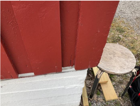
Småsprekker nederst på kledning er registrert.
