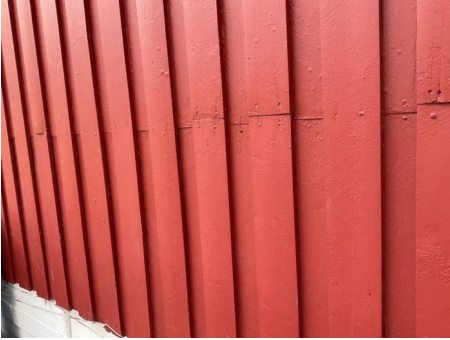
Utvendig kledning er skjøtet uten å skråskjære ender. Dette øker risikoen for fuktopptrekk i endevend.
