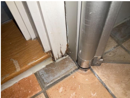
Treverket ifm dør har fuktskader i nedre del.
