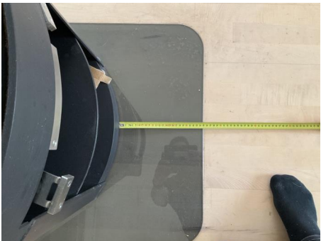
Under 30cm fra ilegget til brennbart gulv.
