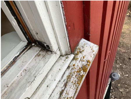
Vannbrettbeslag dekker ikke hele vannbrettet. Omramming vindu er ført ned på beslag, risiko for fuktopptrekk.
