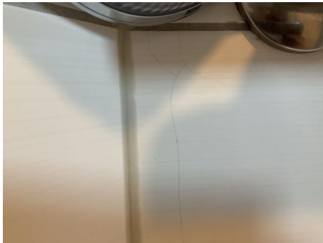
Det er påvist sprekker i fliser.
