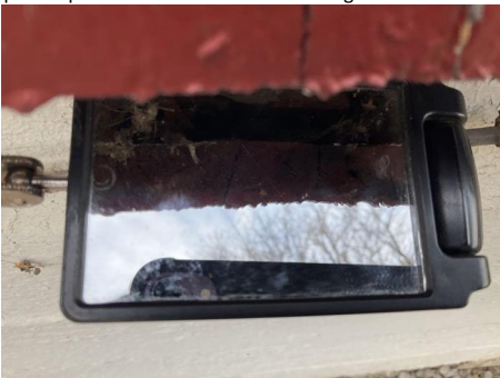
Det er observert glipper / åpninger i overganger / lufting i veggkonstruksjon der mus kan komme inn.
