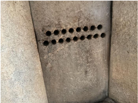
Sprekk i ildfaststien inne i ildstedet.
