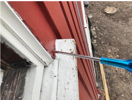
Det er påvist spredte råteskader i bordkledningen
