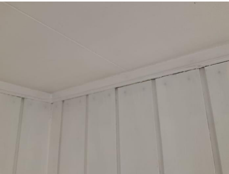
Det er påvist heksesot/støvkondens på overflater.
