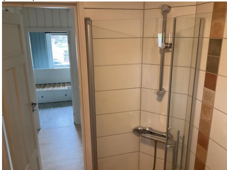
Det er vindu/dør med ikke fuktbestandige materialer i våtsonen.
