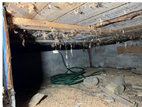
Krypkjeller under tilbygget.
