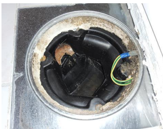
Membran, tettesjikt og overgang til sluk. - [Sluk bad 1 etasje]
