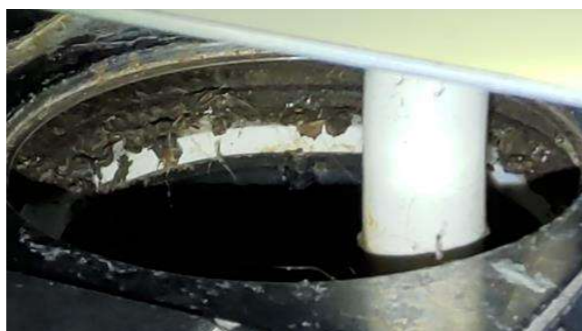
Membran, tettesjikt og overgang til sluk. - [Sluk]
