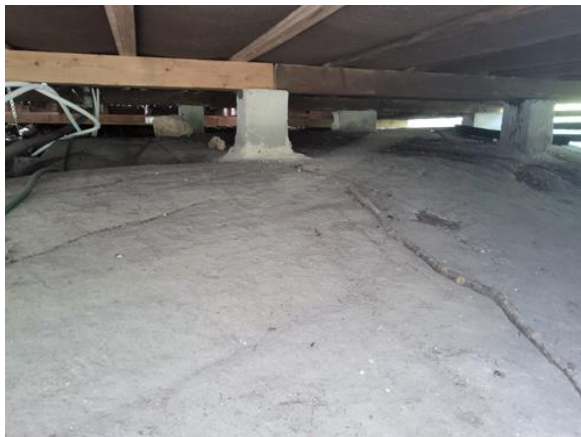
Beskrivelse - [Søylefundamenter på fjell]
