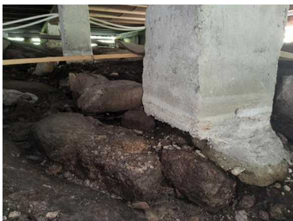
Grunnmur, fundamenter - [Under gravde søylefundamenter]
