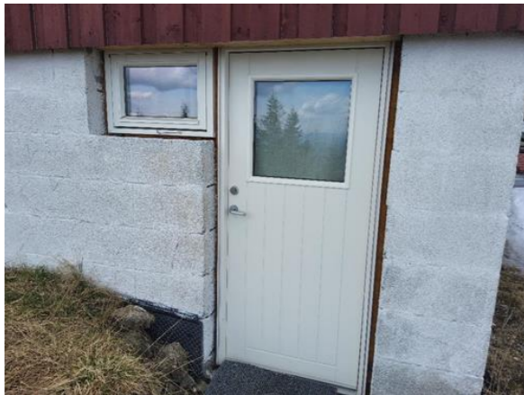
Utvendig - [Dør og vindu med manglende innramming/tetting]
