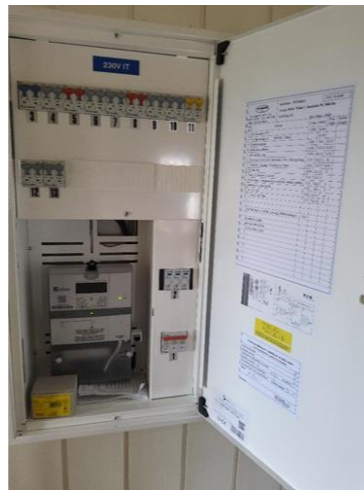
Elektrisk anlegg - [Sikringsskap med kursfortegnelse]
