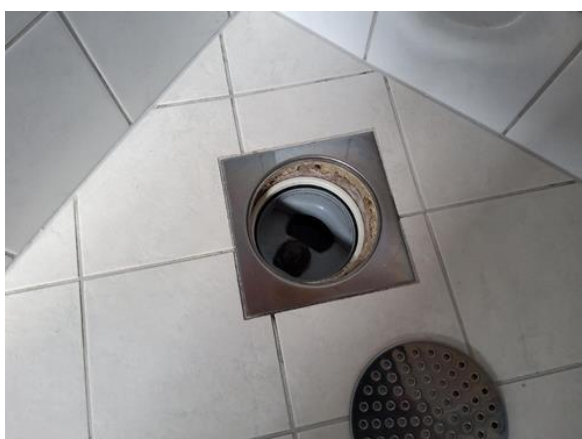
Membran, tettesjikt og overgang til sluk. - [Sluk bad 1. etg.]
