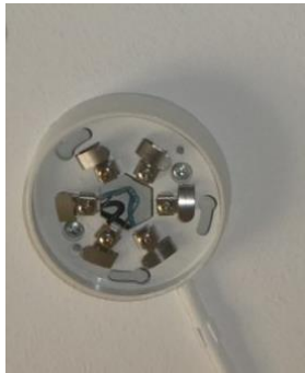
Punkt hvor røykvarsler ikke var montert.
