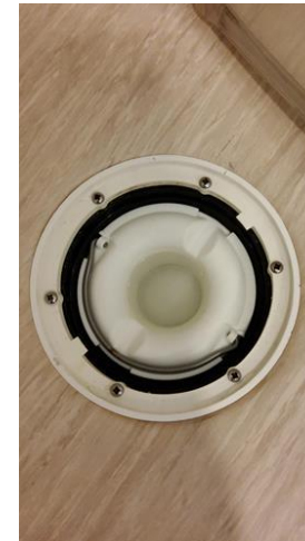
Membran, tettesjikt og overgang til sluk. - [Sluk på bad]
