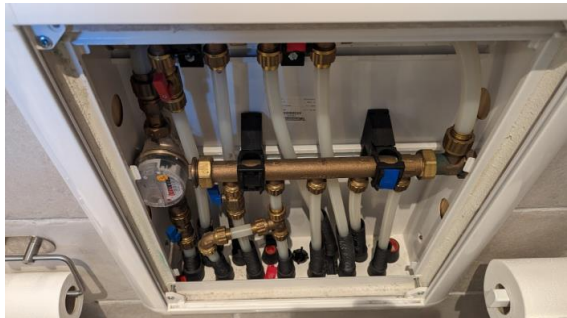
Fordelerskap for rør-i-rør på hovedplan
