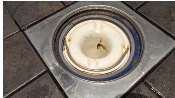
Sluk med synlig mansjett og klemring
