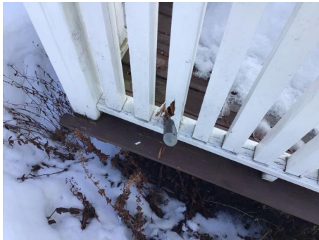
Råteskader i rekkverk.
