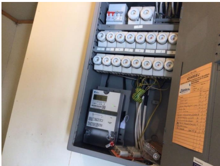
Sikringsskap i trapperom. To automatsikringer.
