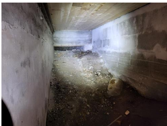
Kommentar - [Liten inspeksjonsmulighet i krypekjeller]
