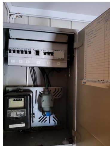
Elektrisk anlegg - [Sikringsskap med kursfortegnelse og teller til hybel]
