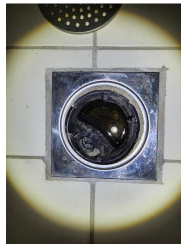
Bad - [Sluk bad kjeller]
