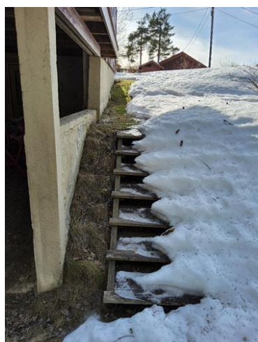
Utvendig - [Snødekt trapp i terreng]
