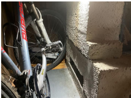
Det registreres sprekker i peis og fundament. Ser ut til at fundamentet har beveget seg/vridd seg.
