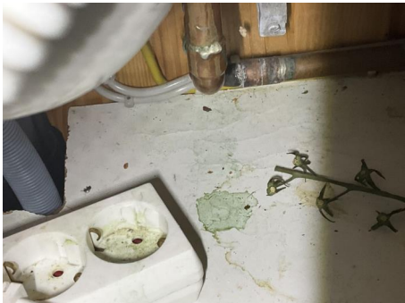
Dryppmerker trolig etter kondensering utvendig på rør.
