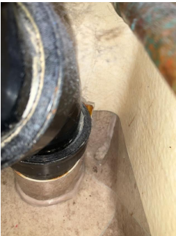
Beleggets oppkant er ikke sveiset med 45 gr vinkel i hjørnene.
