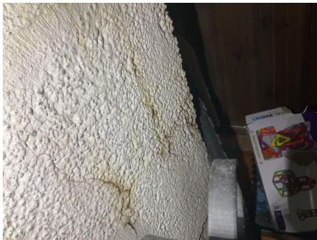
Gjennomslag av sot i sprekker på baksiden av peisen.
