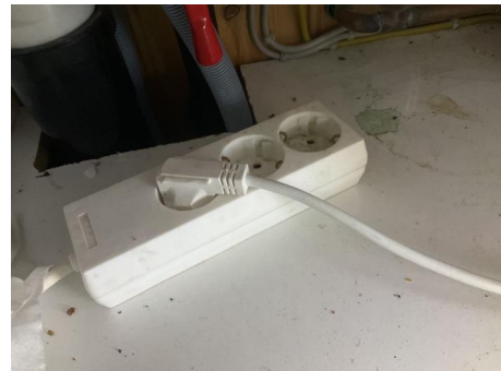
Kjøleskap er tilkoblet skjøteledning. Forholdet bør konfereres med elektriker.
