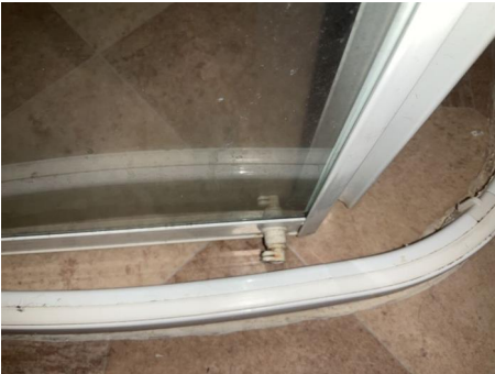
Den ene dusjdøren er løs i nedre del.
