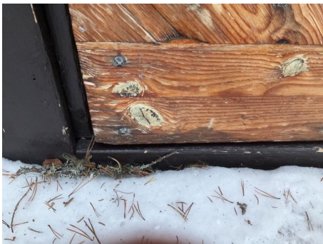
Misfarging og begynnende fuktskade.
