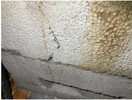
Det registreres sprekker i peis og fundament.
