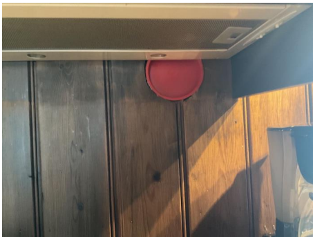
Hull i vegg over komfyr. Hullet er tildekket med lokk
