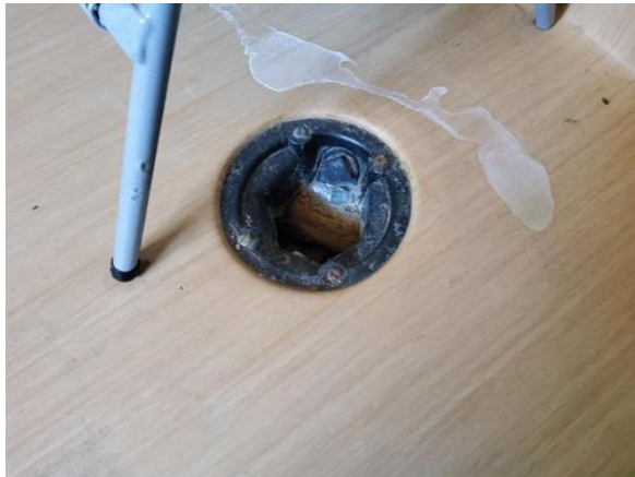
Membran, tettesjikt og overgang til sluk. - [Sluk vaskerom 33 B]
