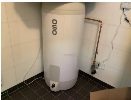
Varmtvannsbereder hoveddel.
