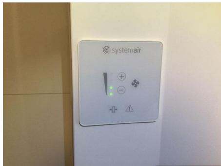
Kontrollpanel på ventilasjonsanlegg.
