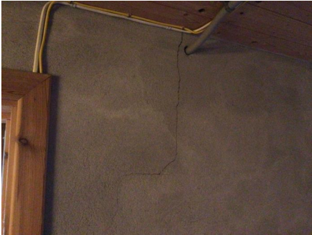
Fuktskade
