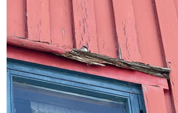
Råteskadet omramming på vindu i 2. etasje.
