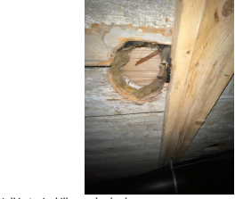
Hull i etasjeskiller under bad.
