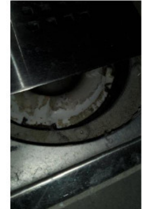
Membran, tettesjikt og overgang til sluk. - [Sluk vaskerom]
