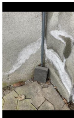
Grunnmur, fundamenter - [Grunnmur]
