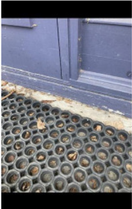
Dører og vinduer - [Ytterdør kjeller]
