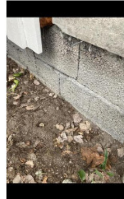
Grunnmur, fundamenter - [Grunnmur]
