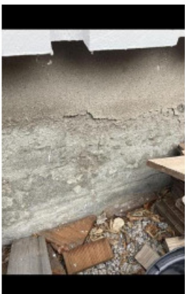
Grunnmur, fundamenter - [Grunnmur]
