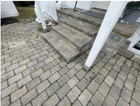
Rekkverk mangler.
