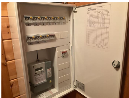
sikringsskap med automatsikringer
