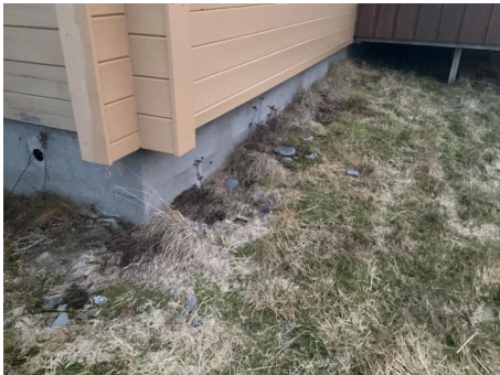
grunnmur ingen riss eller sprekker funnet
