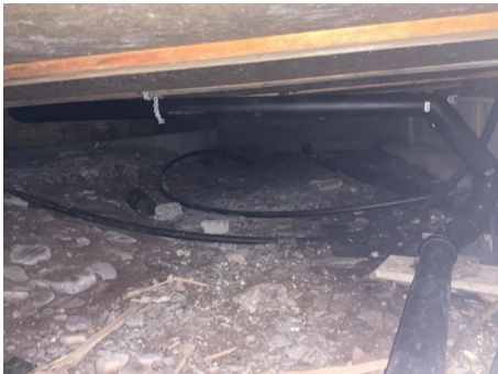
krypkjeller, mangler plast på byggegrunn
