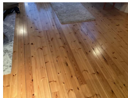
noe mindre glipper i furugolv.
