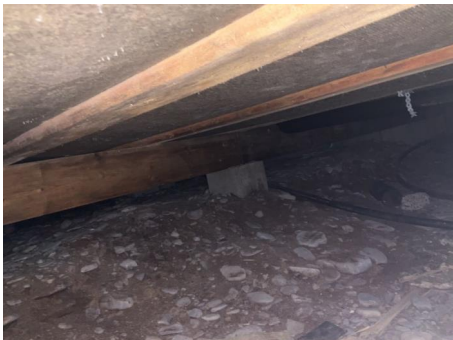
krypkjeller, mangler plast på byggegrunn
