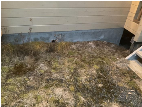
grunnmur ingen riss eller sprekker funnet
