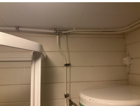
vannledninger av kobber
