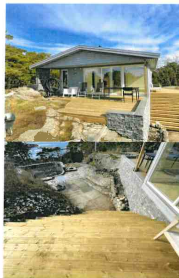
Rekkverk mangler
