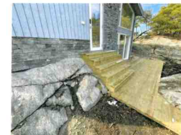
Mangler rekkverk
