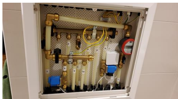
Hovedstoppekran - [Vannskap på bad med hovedstoppekran]
