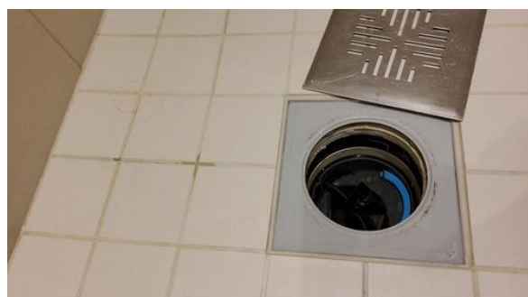
Membran, tettesjikt og overgang til sluk. - [Sluk på bad]
