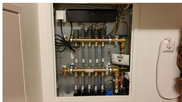
Vannbåren varme - [Vannskap i bod]
