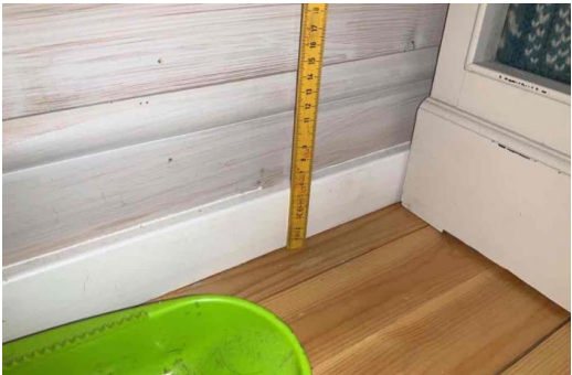
påvist noe høydeavvik på gulv i stue
