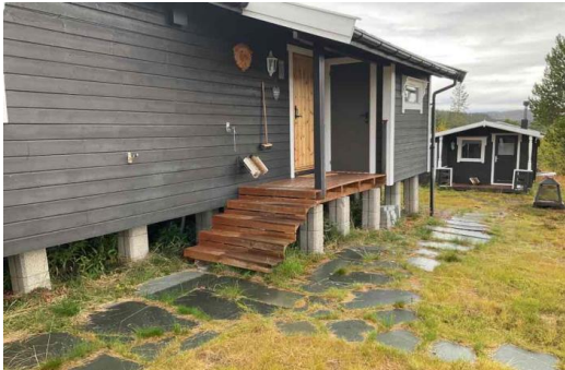
inngangstrapp mangler rekkverk på deler av trappen.
