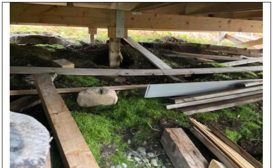
noe svak bæring for uteboden. bør forsterkes
