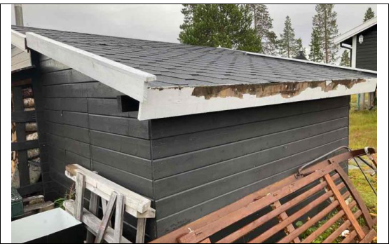
mangelfull utførelse av ytterka på deler av anneks, har ført til vanninnsig i vedsjå
