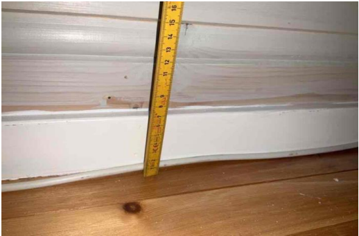
påvist noe høydeavvik på gulv i stue
