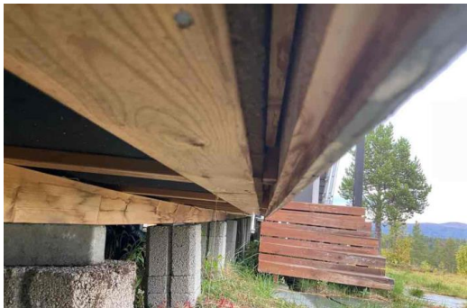
overgang kledning/reisverk og bjelkelag
