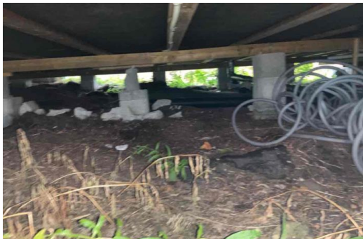
søylepunkt hvor lettklinkerblokk er fjernet og betongsøylke står igjen, forsøkt justert.
