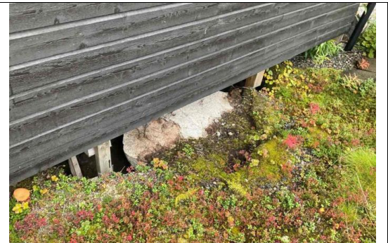
hull rundt enkelte søyler til bod, bør fylles opp og søyle kappes kortere
