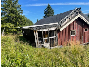
Manglende bordkledning.
