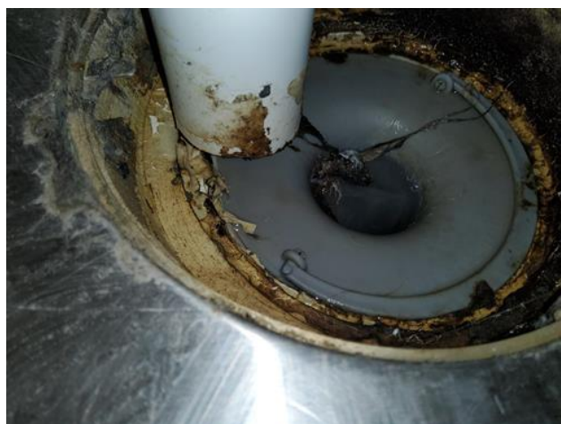
Avløpsrør (ink. sluk) - [Sluk bad]
