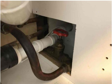
Stoppekran i kjøkkenbenk.
