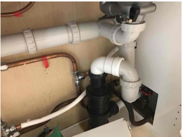
Synlige avløpsrør i plast.
