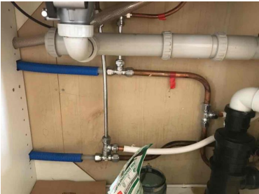
Vannrør i plast og kobber. Det mangler tettemuffer i enden av varerør på rør-i-rør-system
