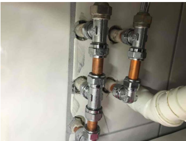
Det er usikkert om rørgjennomføringene er riktig utført.
