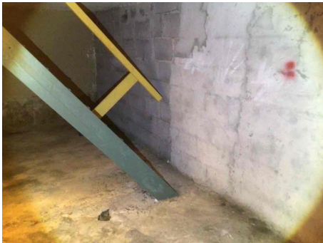
Noe utbuling på Lecamuren. Hull i gulv, tydelig bule på gulv.
