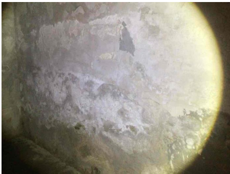
Behov for puss og overflatebehandling, enkelte småsprekker.
