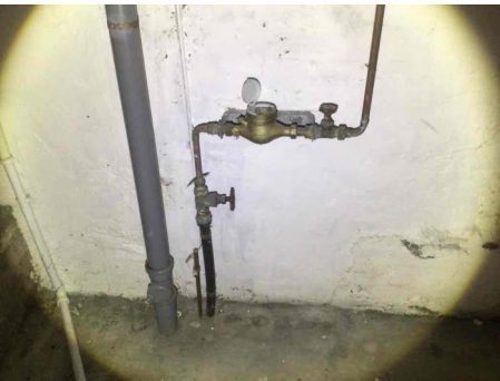
Vanninntaket med måler og stoppekran.
