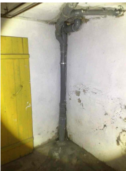
Vanninntaket med måler og stoppekran.
