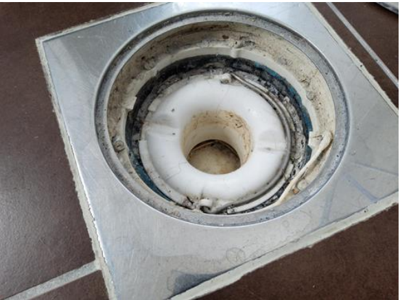
Avløpsrør (ink. sluk) - [Hovedsluk på bad]
