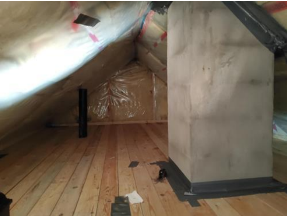
Loft - uinnredet / råloft - [Loft]
