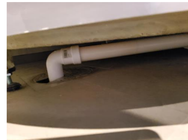
Avløpsrør (ink. sluk) - [Sluk på bad]
