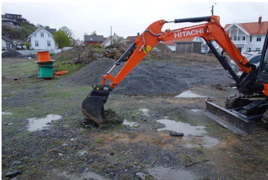
Bilde 1+2. Gravehull 1, sør for borehull 3. Fyllmasser over blandingsleire over leirig sandig steinig silt.
