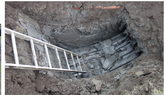
Bilde 3+4. Gravehull 2, sør for borehull 5. Jord over blandingsleire over leirig sandig silt, mindre stein.
