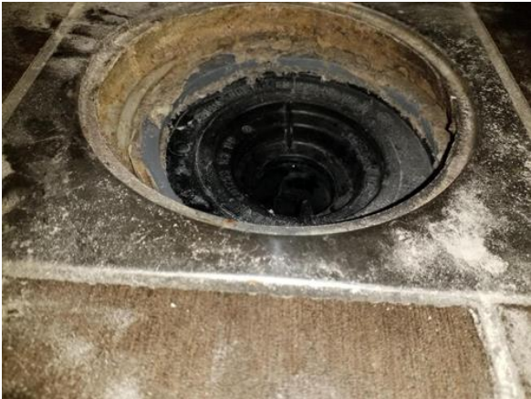
Avløpsrør (ink. sluk) - [Sluk, bad utleiedel]
