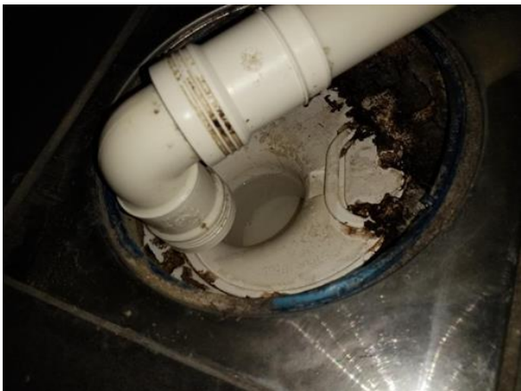
Avløpsrør (ink. sluk) - [Badekarssluk, bad hoveddel]
