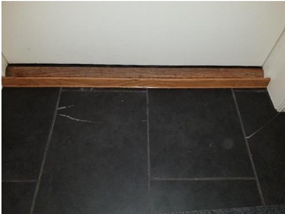
Overflater gulv - [Sprekker ved ytterdør, utleiedel]
