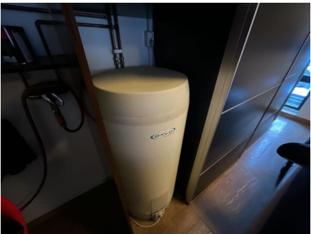
Varmtvannsbereider på ca 160 liter fra 2005 plassert i garasje.
