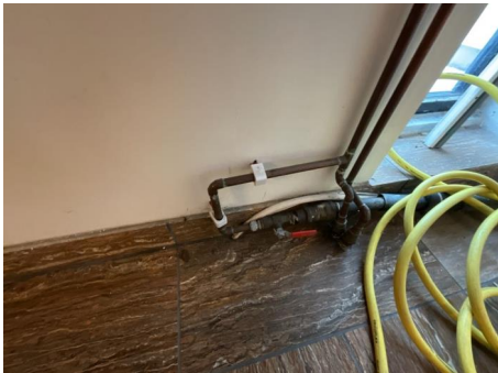
Innvendig hovedstoppekran er plassert i garasje.
