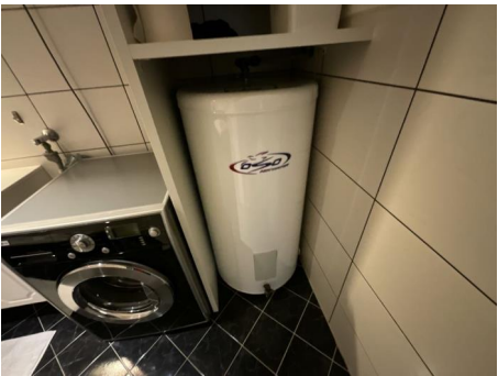
Varmtvannsbereider på ca 200 liter fra 2005 plassert på bad underetg.
