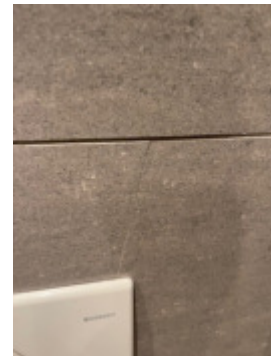
1 sprukket flis ved trykknapp for vegghengt klosett
