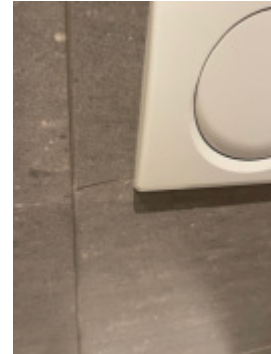
1 sprukket flis ved trykknapp for vegghengt klosett
