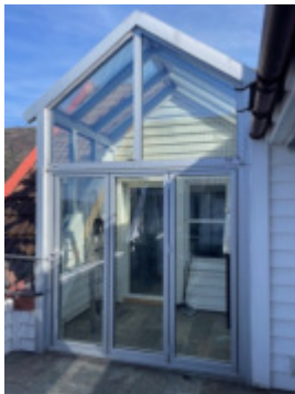
Terrassedør fra kjøkken til vinterhagen er fra 2020
