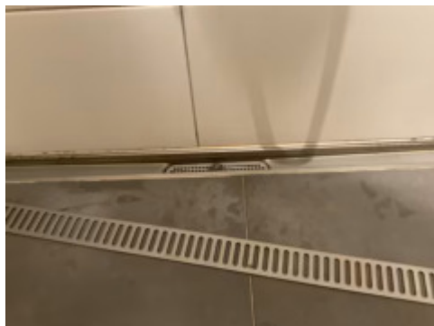
Slukrenne i dusj.
