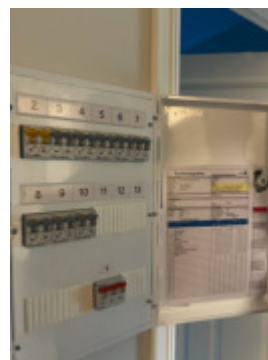
Sikringsskap i sokkelleilighet i underetasje
