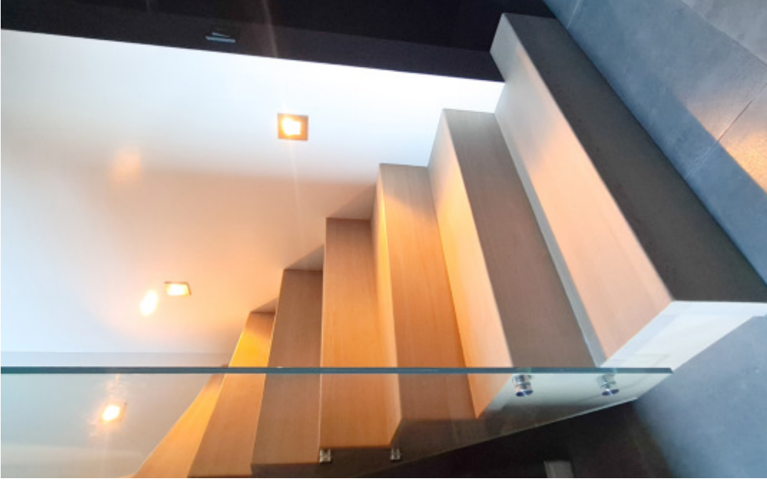
Trinn: Lukkede trinn fra 1.etg til 2.etg. Åpne trinn fra 2.etg til Loft. Ingen overheng mellom opptrinn og inntrinn.
