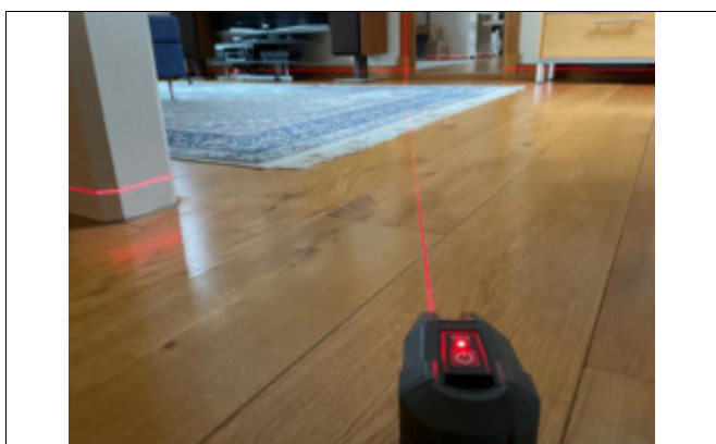
Nivellering loftstue, avvik, ca. 10-20 mm
