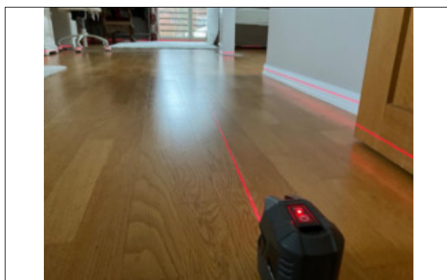
Nivellering soverom, avvik, ca. 10-20 mm
